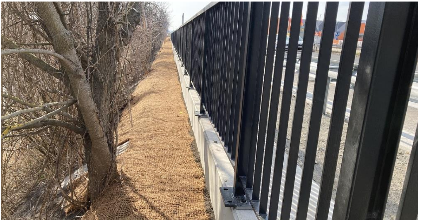
Popisek: Provedení úpravy svahů včetně nové opěrné zdi, díky které mohlo dojít k rozšíření. (© PORR)
