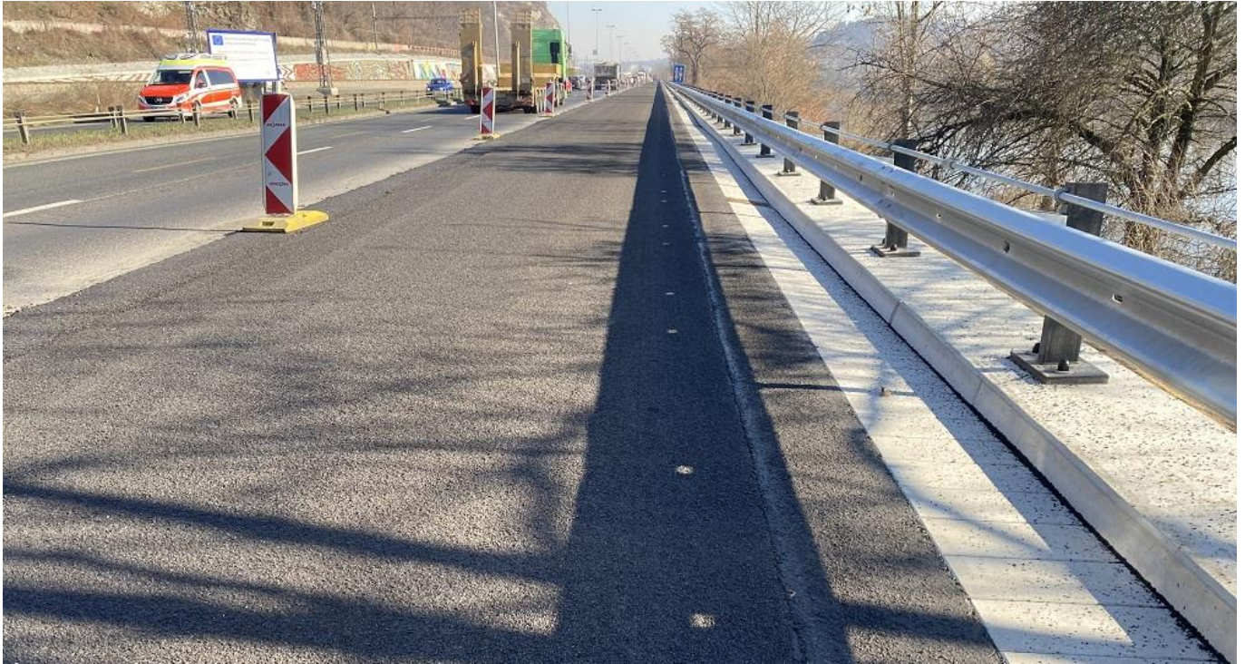
Popisek: Dokončený buspruh na Strakonické ulici (© PORR)
